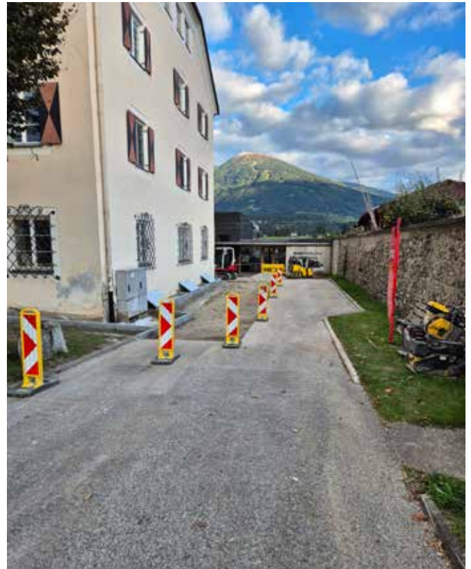
Trockenlegung UG Waidburg und Asphaltierungsarbeiten
